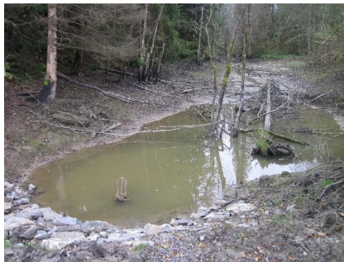
Figur 1 Fordrøyningsdam før innløpet til lukningsanlegg
